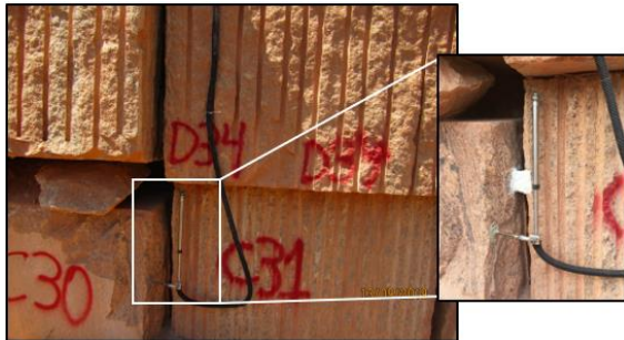
Figura 9. Instrumentado instalado no ponto 3.
