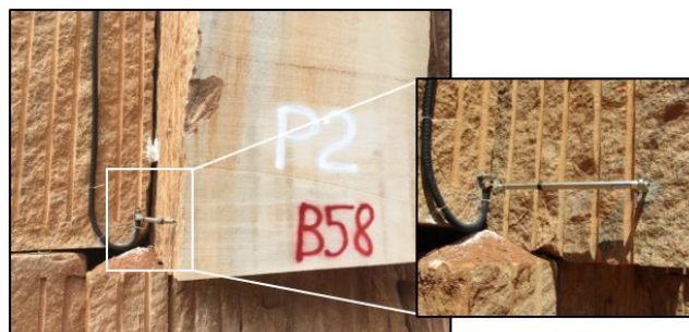
Figura 8. Instrumentado instalado no ponto 2.
